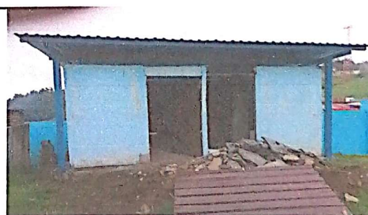
Foto 12: SUMINISTRO DE MATERIAL DE PANELES PRE FABRICADAS (No incluye mano de obra)
