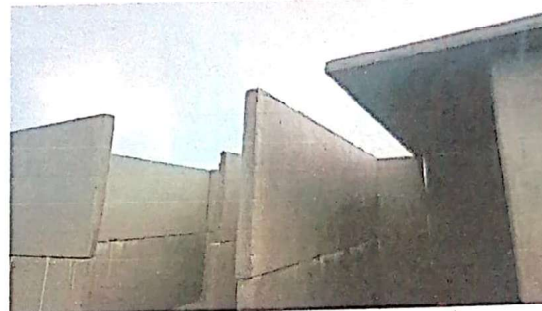
Foto 8: SUMINISTRO DE MATERIAL DE PANELES PRE FABRICADAS (No incluye mano de obra)
