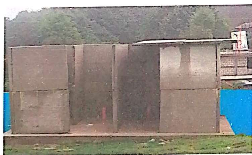
Foto 9: SUMINISTRO DE MATERIAL DE PANELES PRE FABRICADAS (No incluye mano de obra)
