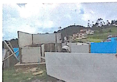
Foto 10: SUMINISTRO DE MATERIAL DE PANELES PRE FABRICADAS (No incluye mano de obra)
