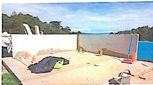
Foto 7: SUMINISTRO DE MATERIAL PANELES PRE FABRICADAS (No incluye mano de obra)
