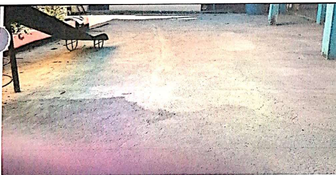
Mantenimiento de pavimento 3,000 PSI
