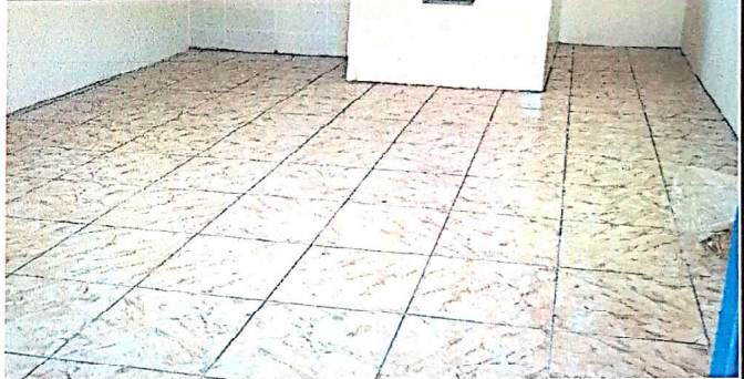
Sustitución de piso por piso cerámico en cocina
