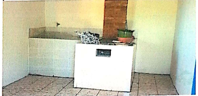
Remozamiento de plancha más lavatrastos con azulejo
