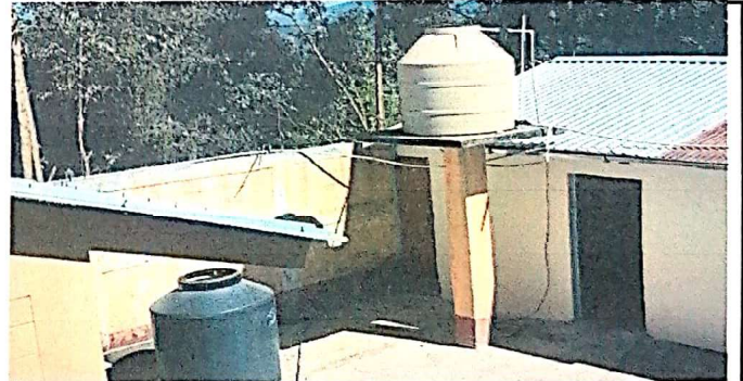
Sustitución de depósito de agua
