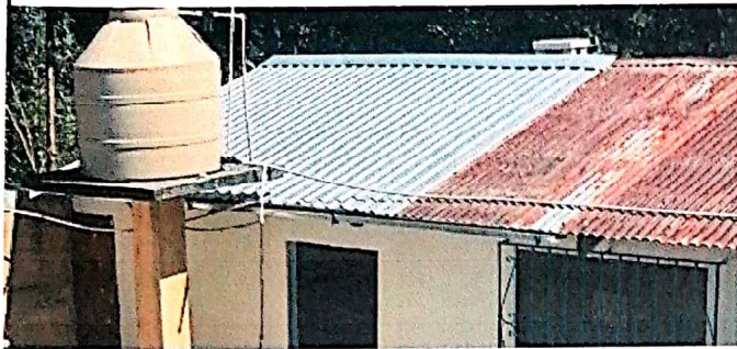
Sustitución de techo más mano de obra
