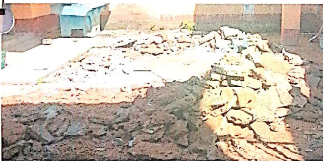
Mantenimiento de pavimento 3,000 PSI
