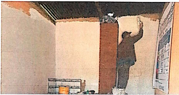
remozamiento de paredes en cocina más pintura lavable
