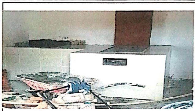
Remozamiento de plancha más lavatrastos con azulejo
