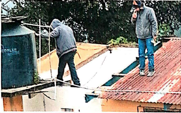
Sustitución de techo más mano de obra
