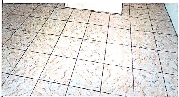
Sustitución de piso por piso cerámico en cocina
