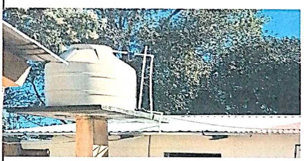
Sustitución de depósito de agua
