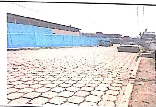
Foto 6: SUMINISTRO E INSTALACION DE PINTURA EXTERIOR
