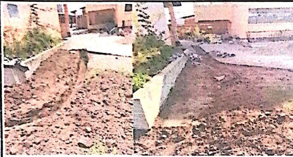
SUMINISTRO E INSTALACION DE DRENAJE
