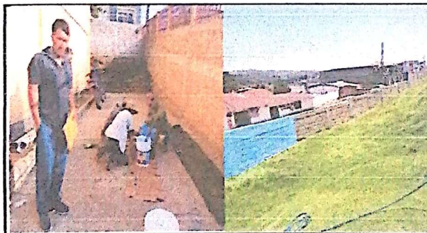
Foto 5: SUMINISTRO Y APLICACIÓN DE PINTURA INTERIORES Y EXTERIORES
