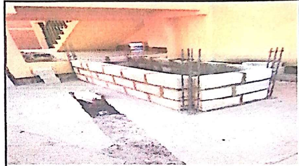
Foto 2: SUMINISTRO E INSTALACIÓN DE LA PILA
