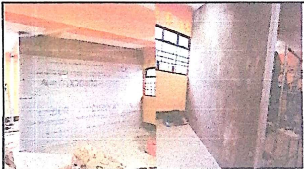
SUMINISTRO E INSTALACION DE PARED BODEGA
