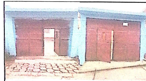
Foto 6: Mantenimiento y Aplicación de Pintura En Portones.
