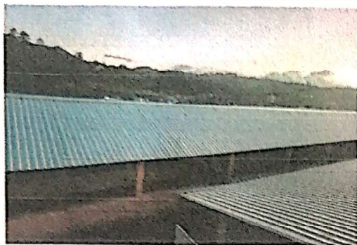
Foto 1: Mejor cobertura en la instalaciones
