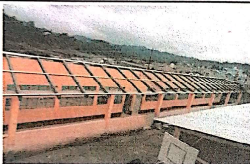
Foto 3: Colocación de molduras y costanera
