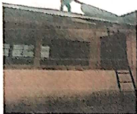
Foto 1: Inicio desmontura de lámina
