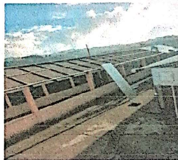
Foto 4: Inicio colocación de lámina
