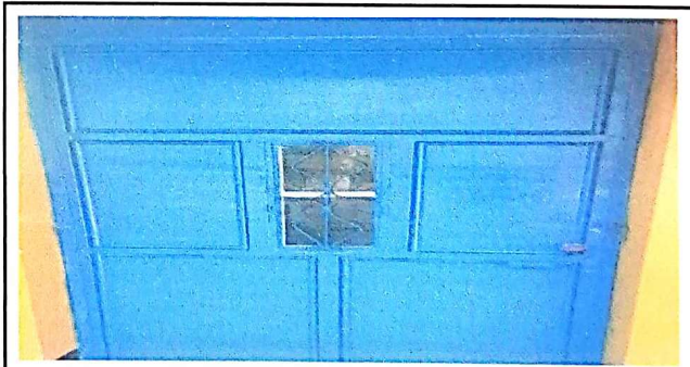
MANTENIMIENTO DE PUERTA
