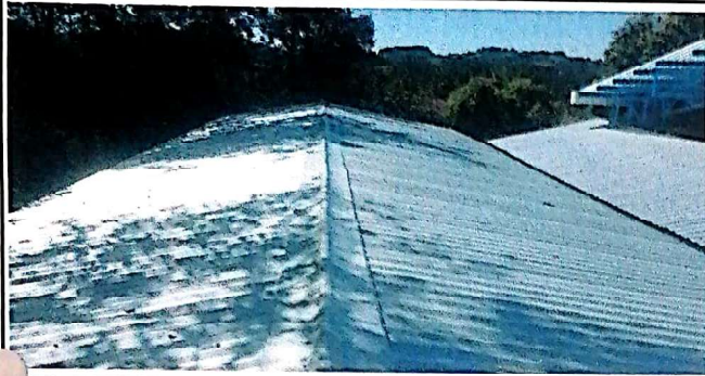
SUSTITUCIÓN DE LAMINA TROQUELADA CALIBRE 26
