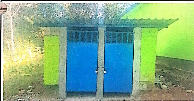
MANTENIMIENTO DE PUERTA
