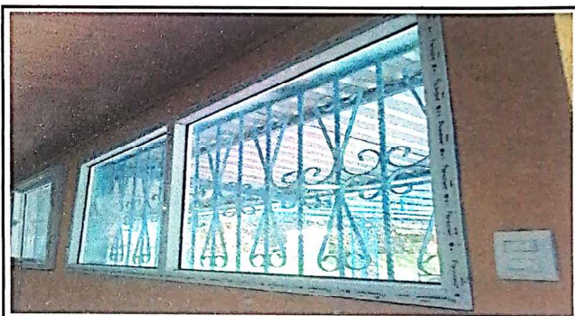
SUSTITUCIÓN DE VENTANAS DE PVC
