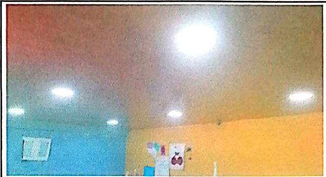
INSTALACIÓN DE CIELO FALSO PVC
