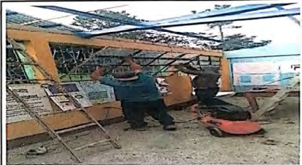
SUSTITUCIÓN DE VENTANAS DE PVC
