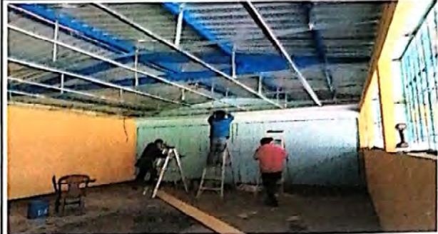
INSTALACIÓN DE CIELO FALSO PVC
