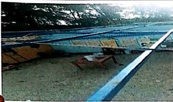
SUSTITUCIÓN DE LAMINA TROQUELADA CALIBRE 26
