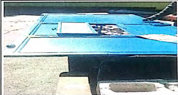
MANTENIMIENTO DE PUERTA
