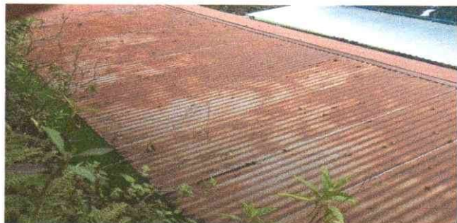
SUSTITUCIÓN DE LAMINA TROQUELADA CALIBRE 26
