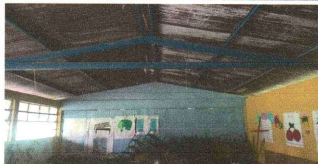
INSTALACIÓN DE CIELO FALSO PVC
