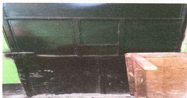
MANTENIMIENTO DE PUERTA
