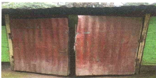
MANTENIMIENTO DE PUERTA
