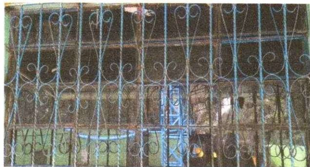
SUSTITUCIÓN DE VENTANAS DE PVC
