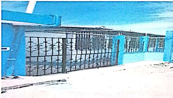
Foto 3: Reparación de portón y puesta de chapa finalizado.
