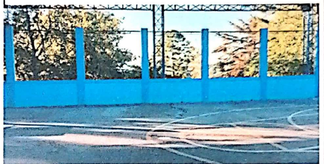
Foto 2: Reparación de paneles finalizado
