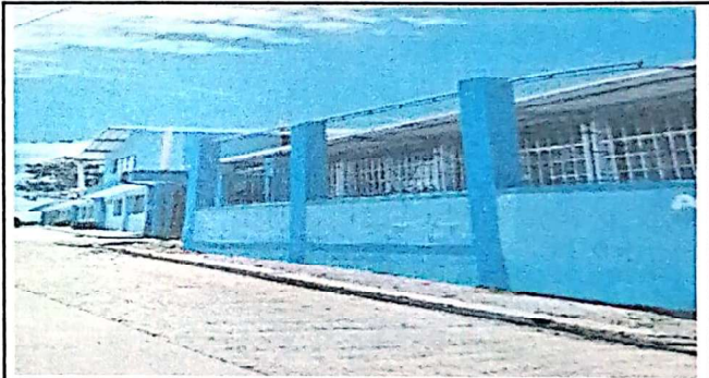
Foto 4: Mantenimiento de pintura de la parte de afuera del establecimiento finalizado
