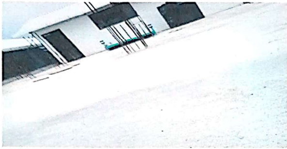
Foto 1: Mantenimiento de Losa terminada
