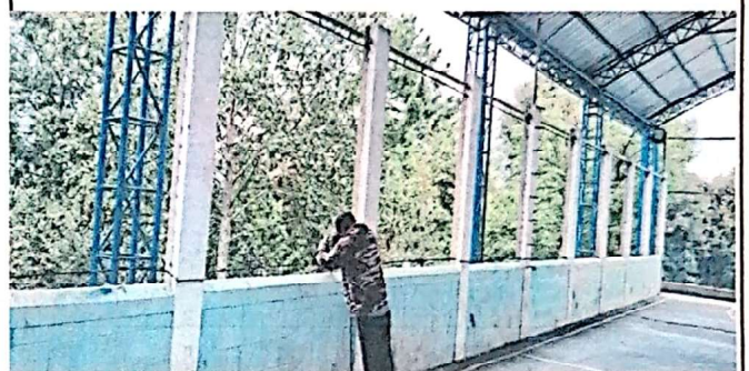
Foto 2: Reparación de paneles de malla.
