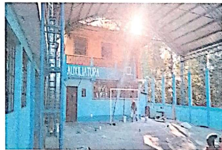
Foto 4: Mantenimiento de pintura en la parte de adentro del edificio escolar
