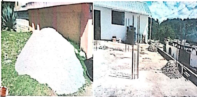
Foto 1: Sustitución de material e impermeabilizante sobre la losa.
