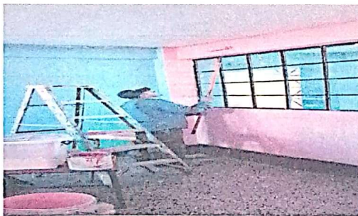
Foto 3: Mantenimiento de pintura dentro de las aulas.
