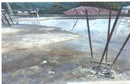
Mantenimiento sobre terraza para drenar el agua, EN TERRAZA PARA 130 M2 (Pegamento monolates sika, refuerzo con malla de gallinero de 2x2 y concreto 3000PSI, acabado con sika techo)
