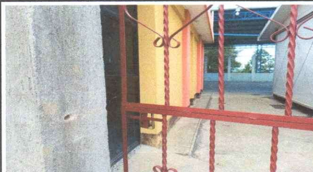
Reparación de portón de ingreso más chapa y mejora de marco que sostiene el portón
