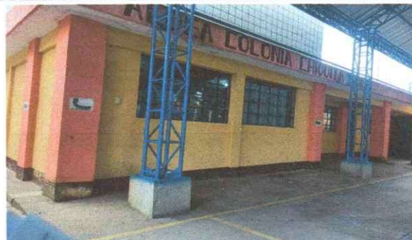
Mantenimiento de Pintura en Escuela y cancha (dos capas de pintura) toda la escuela
