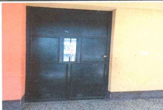
Mantenimiento con pintura de puertas ajustes y revisión de chapas y reparación de puertas de baño
