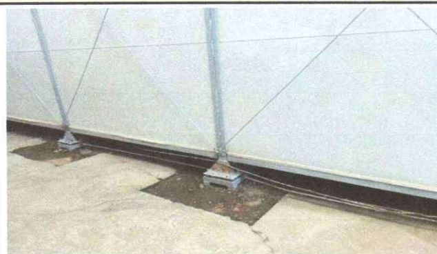
Reparación de solera con block tipo c. de 0.19x0.10x0.20M, para evitar ingreso de animales debajo de aula prefabricadas más solera de 0.10x10 M (altura total incluye incrustado en el suelo 50m)
