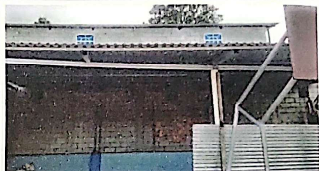
Foto 4: FINALIZADA MANTENIMIENTO DE LA ESTRUCTURA DE METAL
