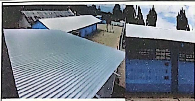
Foto 1: VISTA de LAMINA COLOCADA AL 100%
