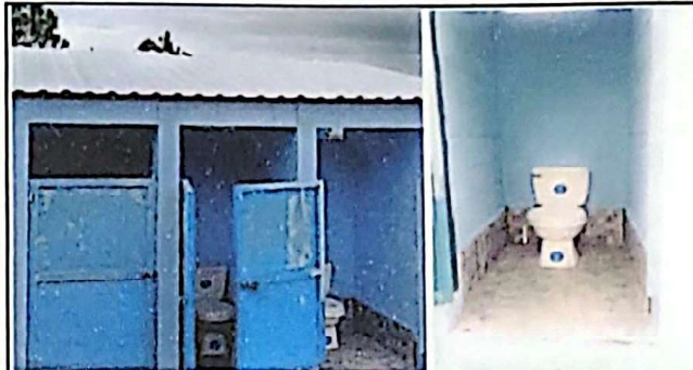
Foto 2: VISTA DE INSTALACIÓN DE BAÑOS FINALIZADO
