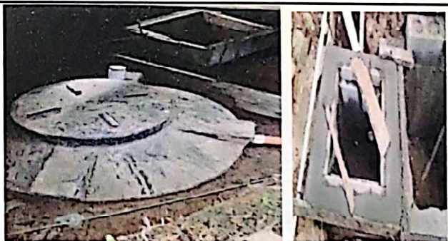
Foto 6: SUMINISTRO E INSTALACIÓN DE BIODIGESTOR CON CAJA DE DRENAJE Y POZO DE ABSORCIÓN FINALIZA
