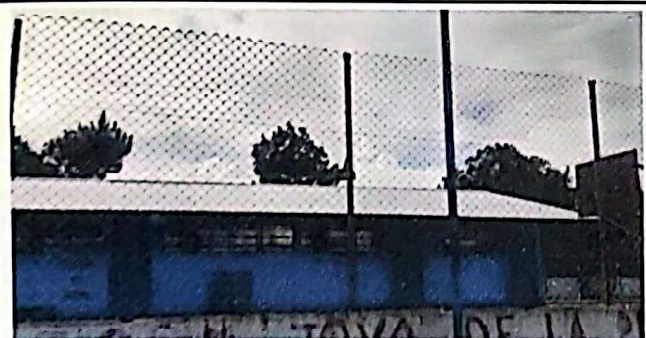
Foto 5: SUMINISTRO E INSTALACIÓN DE MALLA GALVANIZADA CALIBRE 10 FINALIZADO
