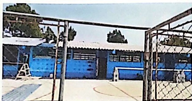
Foto 1: RETIRO DE LÁMINAS ANTIGUAS
