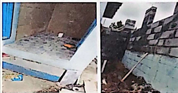
Foto 2: sustitución de letrina por inodoro
