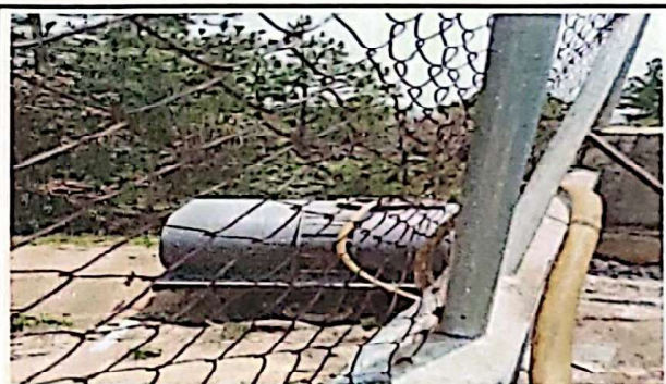
Foto 4: Mantenimiento de fosa con extracción de lodo
