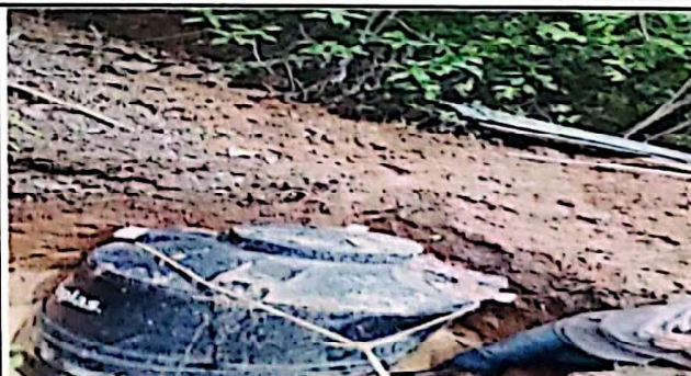
Foto 6: Suministro e instalacion de biodigestor
