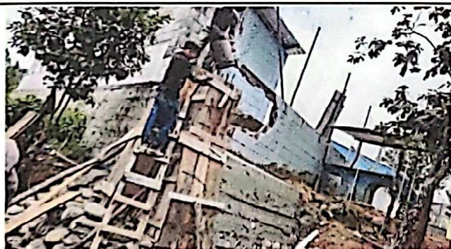
Foto 3: Suministro e instalacion de muro de concreto ciclopeo
