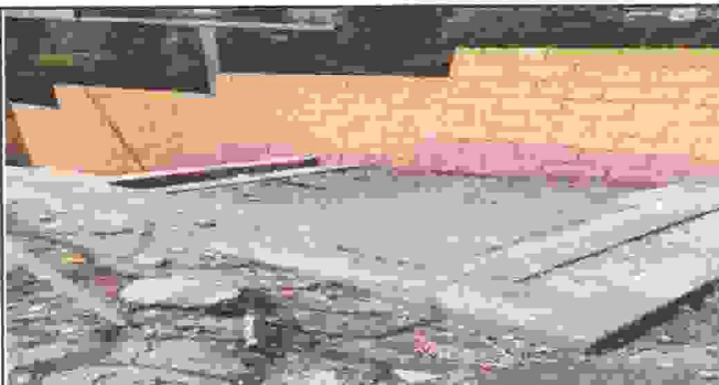
Foto 3: Mantenimiento de piso de patio
