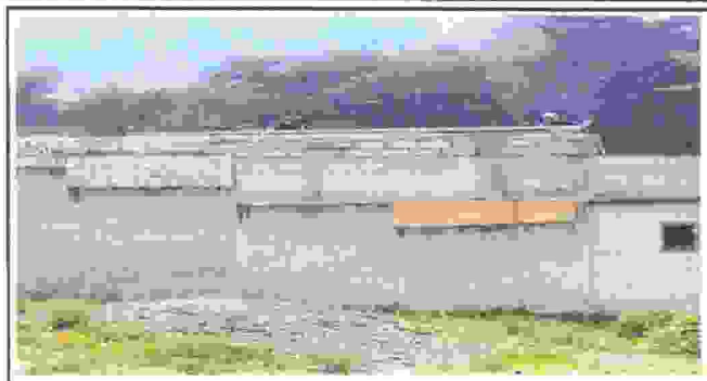
Foto 2: Instalación de techo
