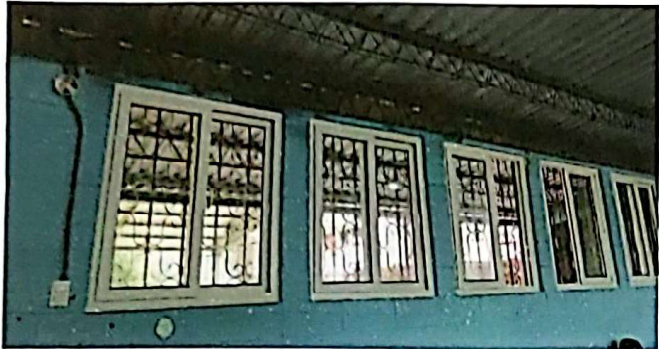
mantenimiento a estructura a soporte de metal con anticorrosivo
