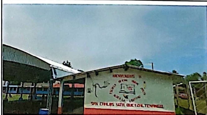
sustitución de lámina, por lamina troquelada calibre 26
