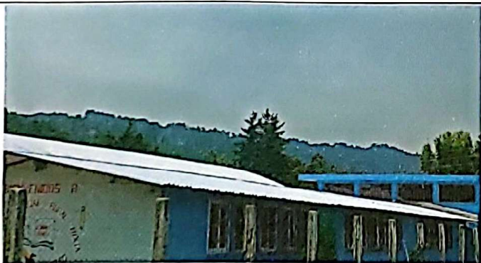
sustitución de lámina, por lámina troquelada calibre 26
