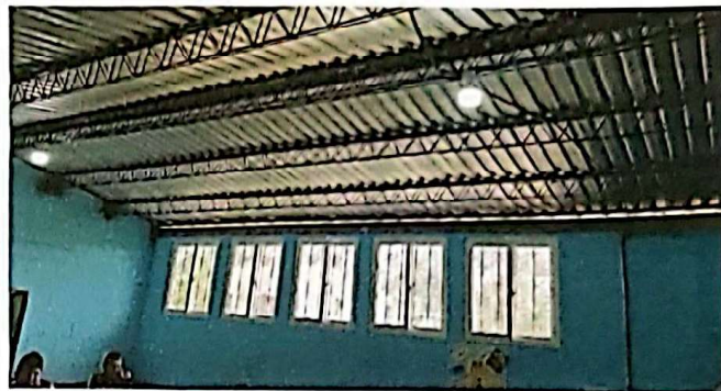
Reparación y sustitución de ventanas
