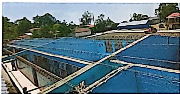
sustitución de lámina, por lámina troquelada calibre 26
