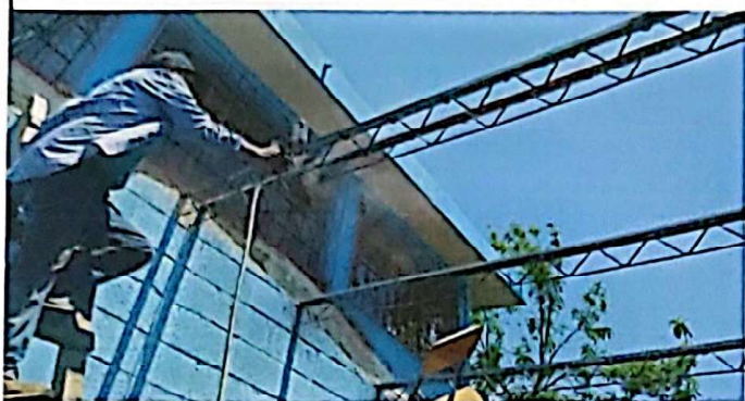
mantenimiento a estructura a soporte de metal con anticorrosivo
