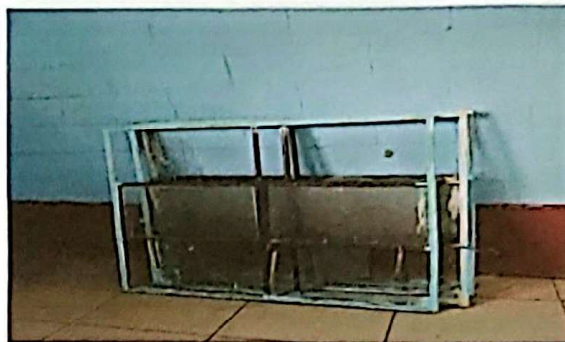
Reparación y sustitución de ventanas
