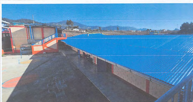
Mantenimiento de cubierta de lámina con pintura anticorrosiva
