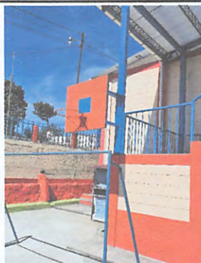
Sustitución de tableros de basquet bol
