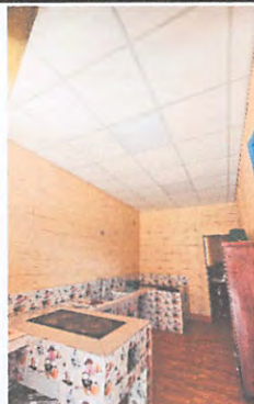
Suministro e instalación de cielo falso reticulado de fibra mineral
