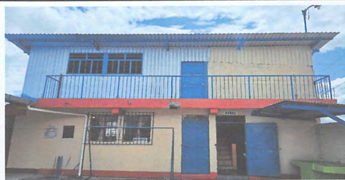
Sustitución a barandas de metal en pasillos
