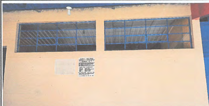
Sustitución de vidrios 5mm
