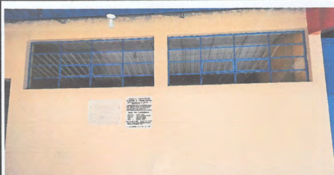
Mantenimiento a estructura de metal de ventana
