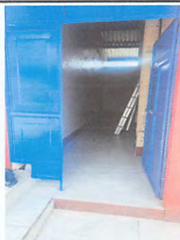
Sustitución de piso en bodega
