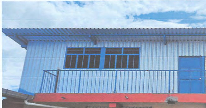
Sustitución de ventanas
