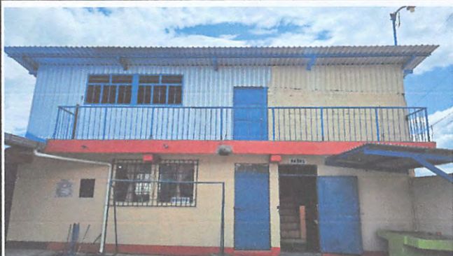
Sustitución a barandas de metal en pasillos
