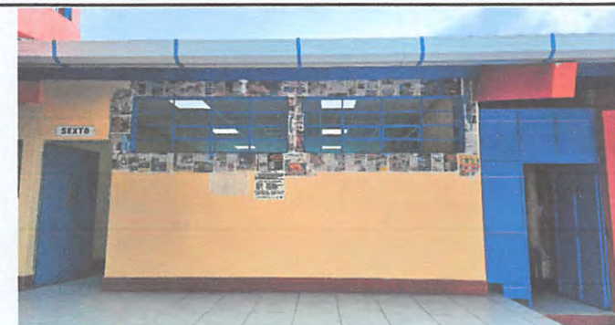
Mantenimiento a estructura de metal de ventana
