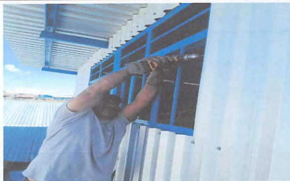
Sustitución de ventana
