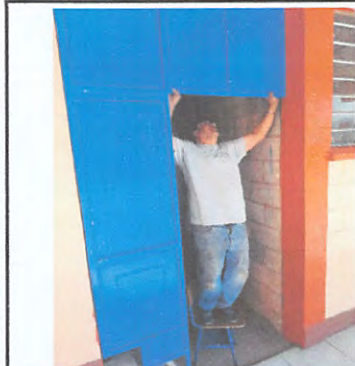
Sustitución de puertas
