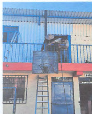
Sustitución de tableros de basquet bol
