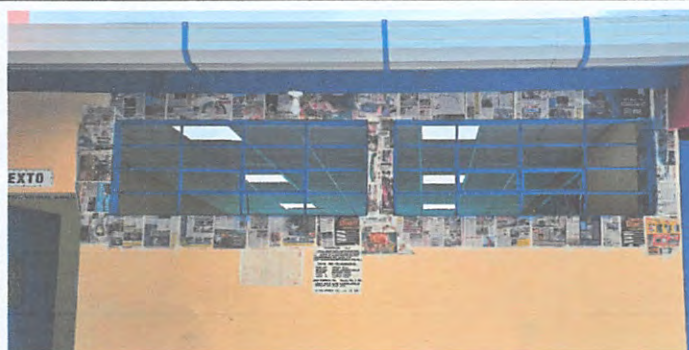
Sustitución de vidrios 5mm
