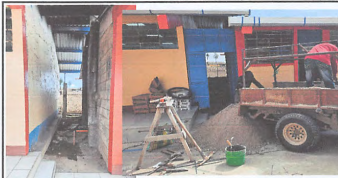
Sustitución de piso en bodega
