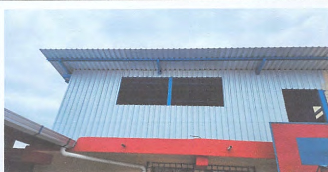
Sustitución de ventana
