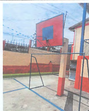
Sustitución de tableros de basquet bol
