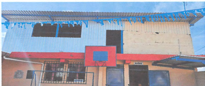
Sustitución a barandas de metal en pasillos
