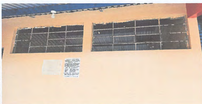
Mantenimiento a estructura de metal de ventana
