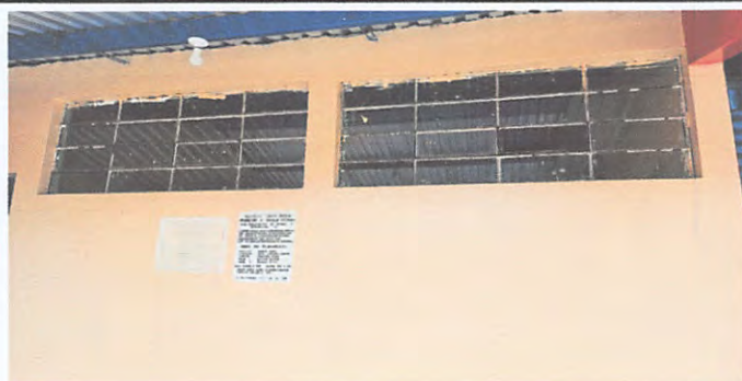
Sustitución de vidrios 5mm
