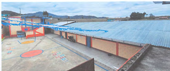
Mantenimiento de cubierta de lámina con pintura anticorrosiva
