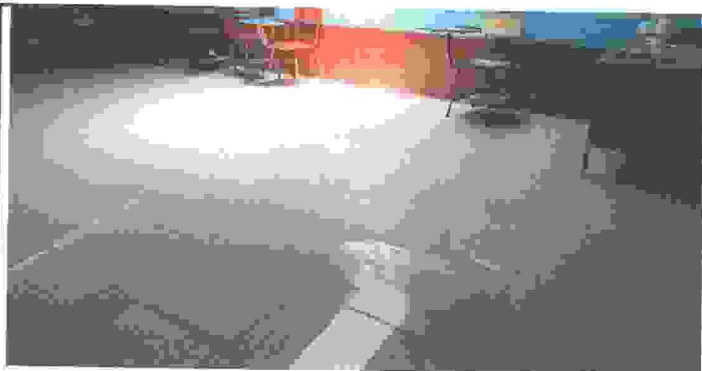
Foto 3: VISTA DE SUMINISTRO E INSTALACIÓN DE PISO PORCELANATO FINALIZADO
