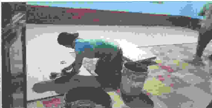
Foto 3: SUMINISTRO E INSTALACIÓN DE piso porcelanato
