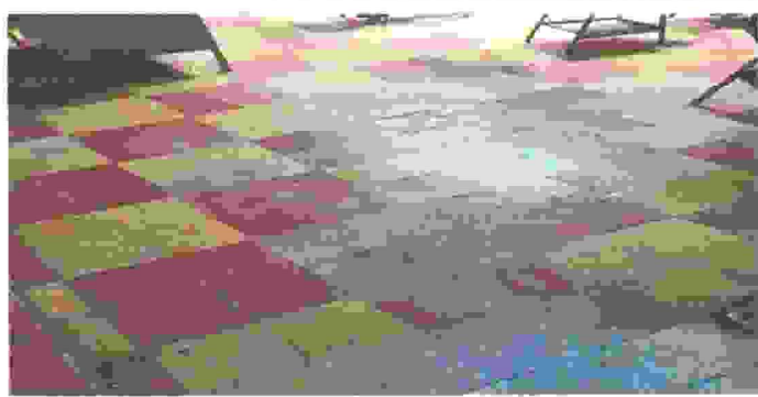
Foto1: suministro e intalacion de piso
