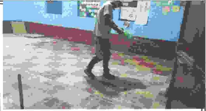
Foto 2: PRIMERA FASE preparacion para el suministro de piso
