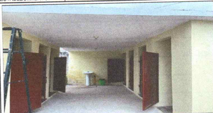
Foto1: Vista reparacion de baños terminado al 100%
