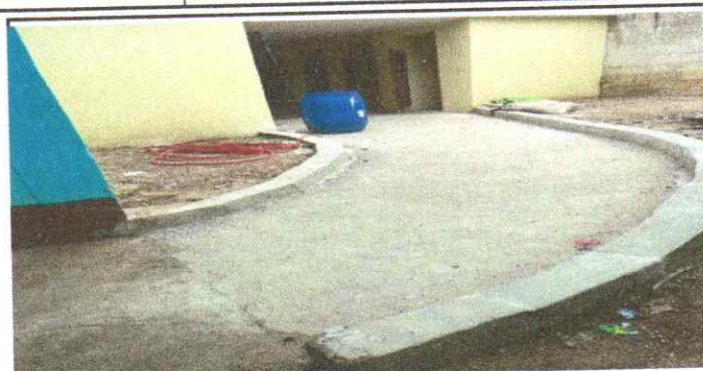
Foto 2: Vista de instalacion torta de cemento frente a los baños finalizado al100 %
