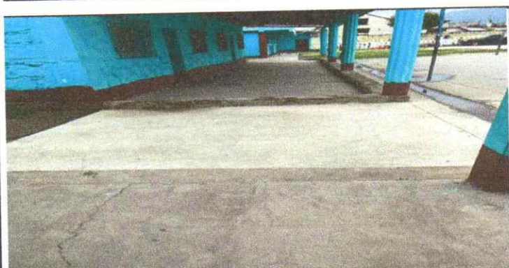
Foto 3: Vista de instacion de torta de cemento entre los edificios finalizado 100%
