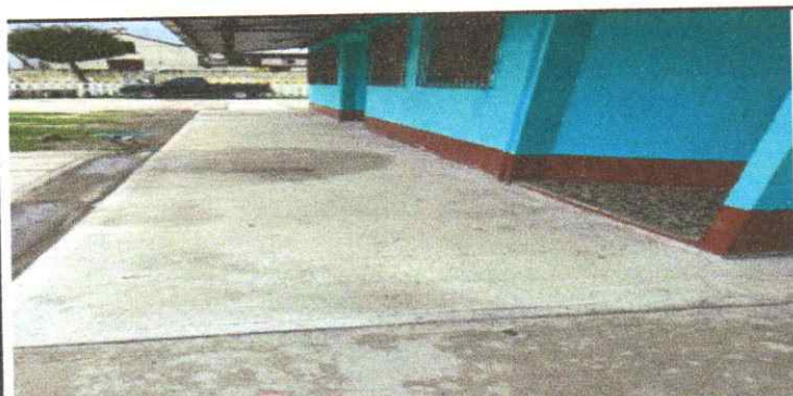
Foto 5: vista final de torta de cemento frente al edeificio de parvulos finlizado el 100%
