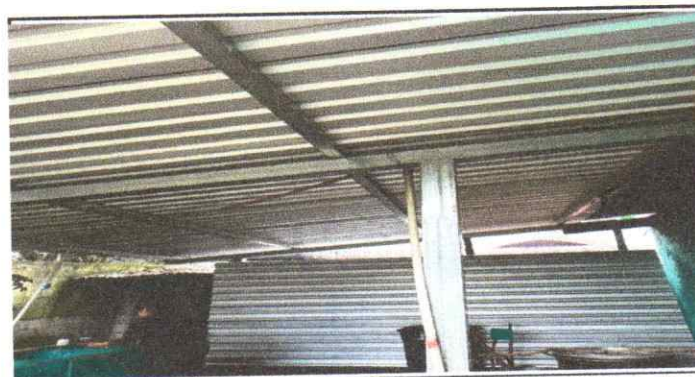
Foto 6: vista final de sustitucion de lamina troquelada cabre 26 de cocina finalizado el 100%
