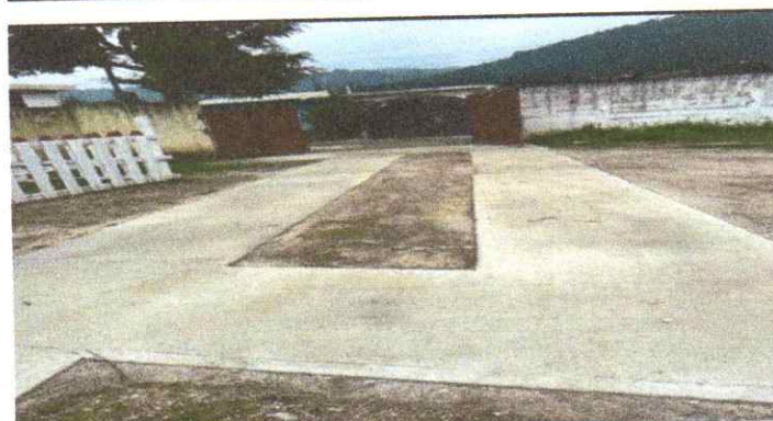
Foto 4: Vista de carrileras de entrada con torta de cemento finalizado el 100 %
