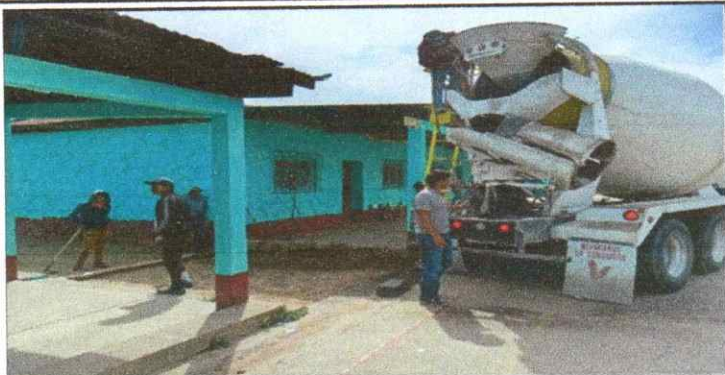
Foto1: instalacion de torta de cemento entre los edificios
