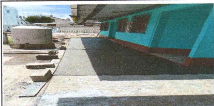
Foto 5: reparacion de torta de cemento frente al edificio de parvulos
