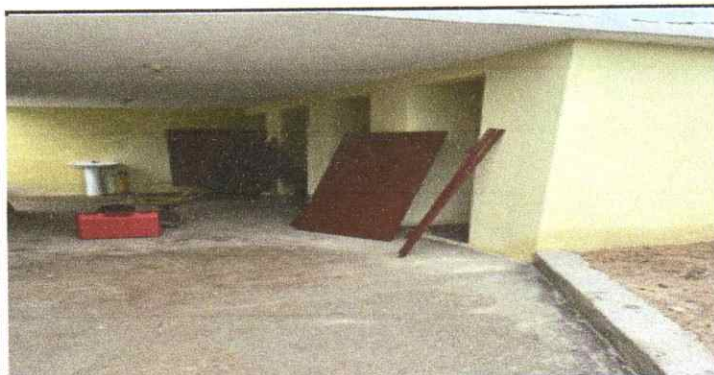
Foto 3: reparacion y mantenimiento de baños
