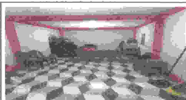
Foto 5: Aquí en esta fotografia ya se terminó la colocación de piso en la dirección del establecimiento.
