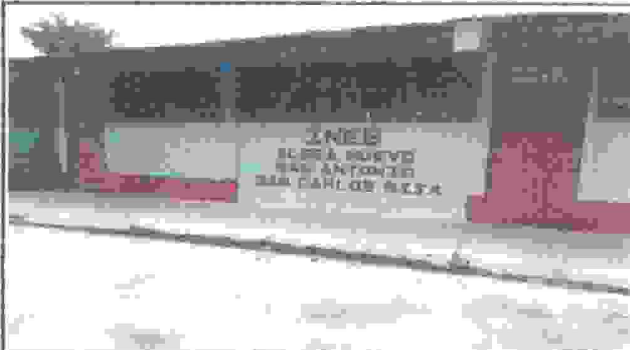
Foto 1: Aquí se esta terminada la parte de enfrente del establecimiento
