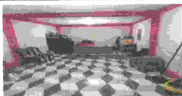
Foto 5: Aquí en esta fotografía ya se terminó la colocación de piso en la dirección del establecimiento.
