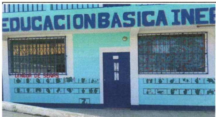
Foto 4: Sustitución de Balcones
