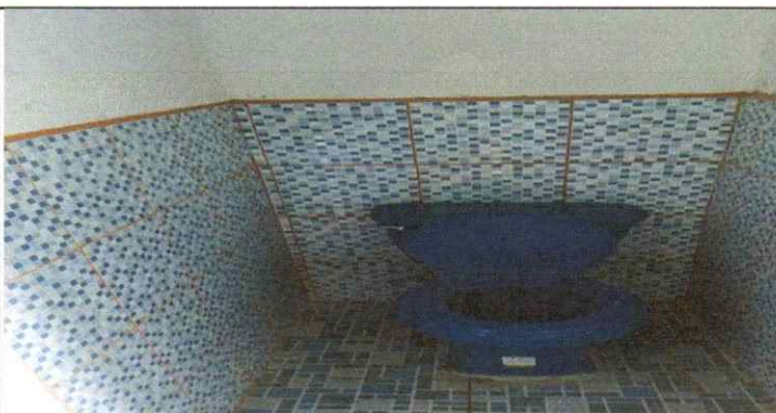
Foto 3: Sustitución de Inodoro Elongado
