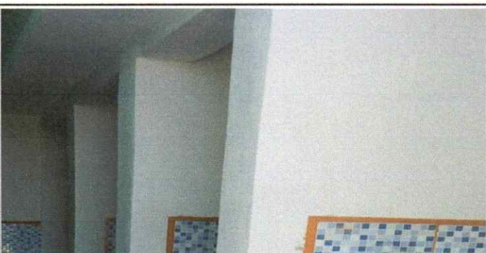
Foto 5: Reparación de Tbería de agua
