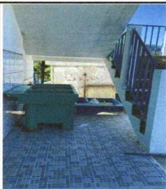
Foto 1: Sustitución de pila de concreto
