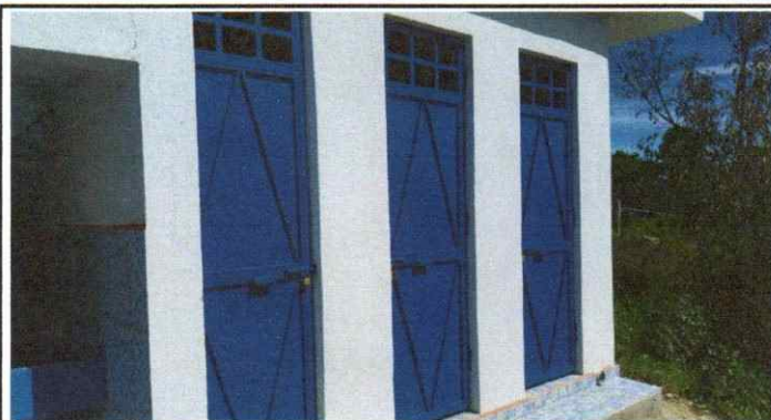
Foto 2: Sustitución de puertas de metal
