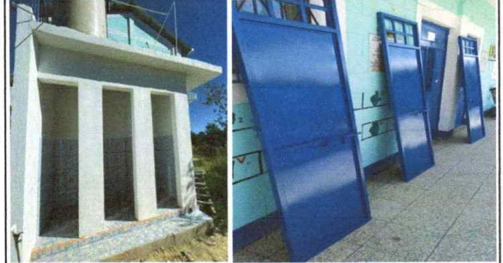
Foto 2: Sustrucción de puertas metálicas
