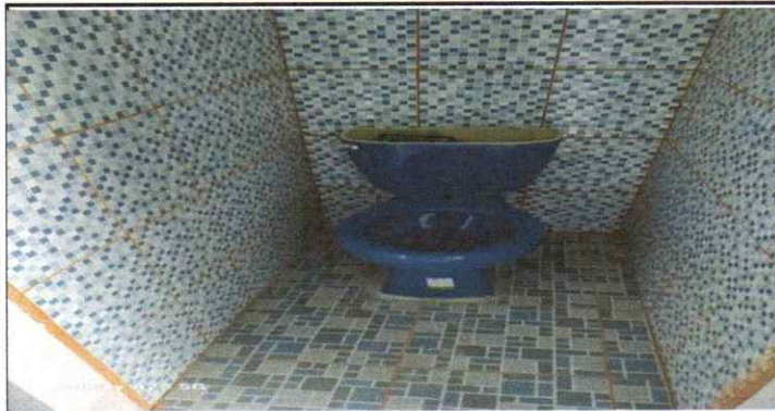
Foto 3: Sustrucción de Inodoro Elongado
