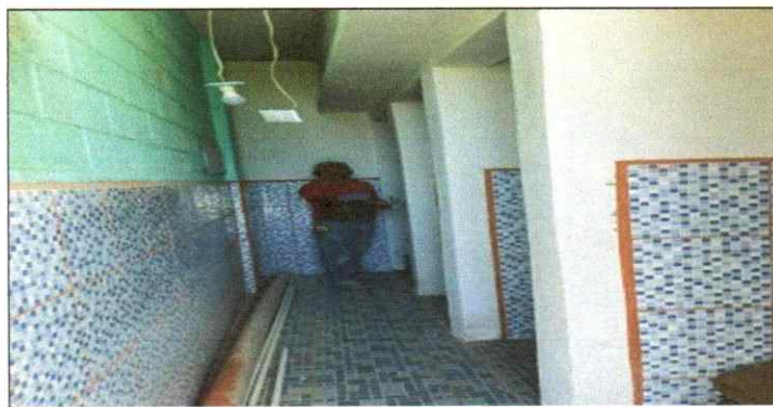
Foto 5: Repareación de tubería de agua
