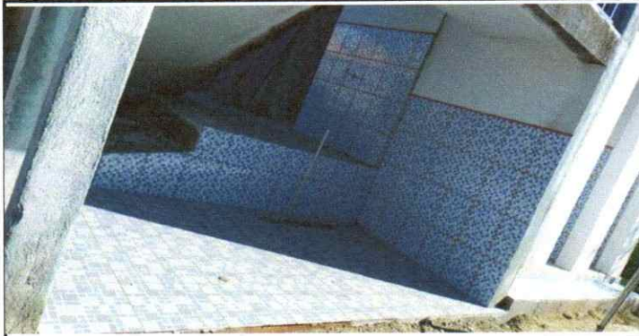
Foto 1: Sustrucción de Pila de Concreto
