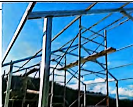
Foto 5: COLOCACION DE BIGA Y COSTANERAS
