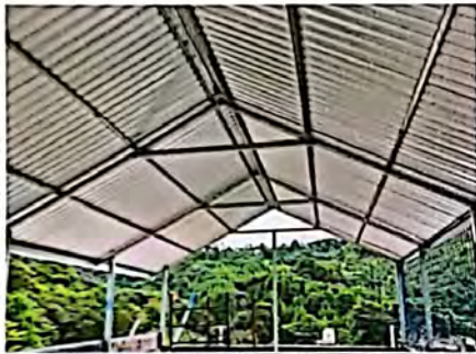
Foto 1: VISTA FACHADA INTERIOR LAMINA COLOCADA AL 100%
