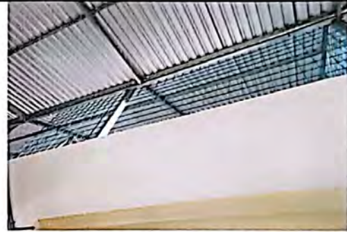
Foto 2: VISTA DE INSTALACIÓN DE LAMINA FINALIZADO
