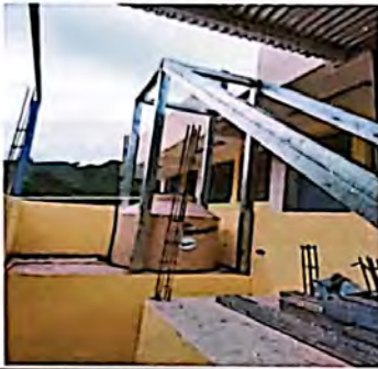
Foto 1: COLOCACION DE COSTANERAS PARA GRADAS
