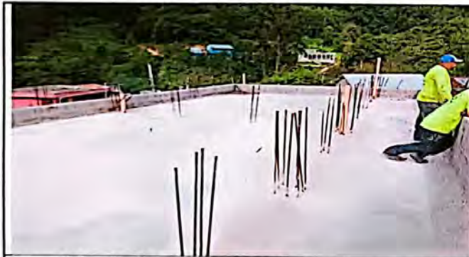
Reparación/ sustitución/ estructura portante de techo
