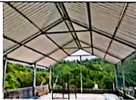
Foto 6: FINALIZA LA COLOCACIÓN DE LÁMINAS
