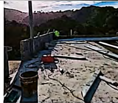
Foto 4: INICIO DE COLOCACION DE PARALES PARA EL ENTECHADO
