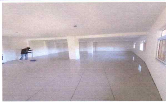
Foto 2: Muros y losa repellido y con blanqueado liso
