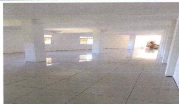
Foto 3: Sustitución de piso cerámico
