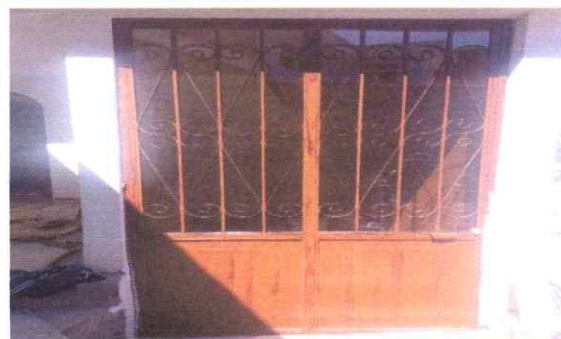
Foto 6. Sustitución de puerta metálica
