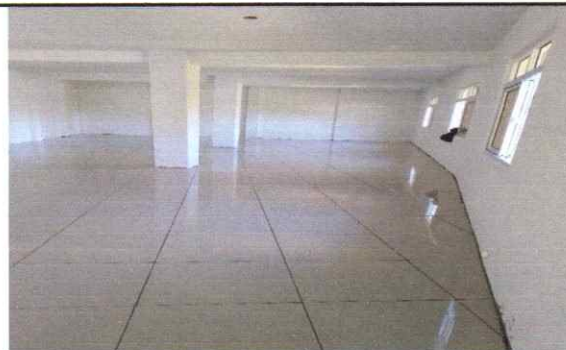
Foto 4: Sustitución de piso cerámico
