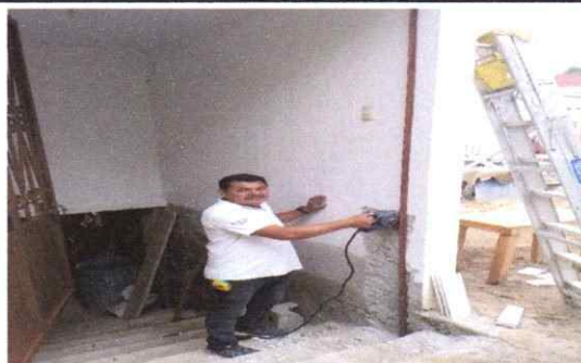
Foto 6: Sustitución de puerta metálica
