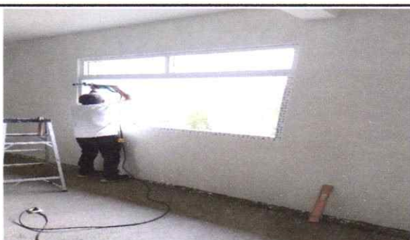
Foto 5: Sustitución de ventanas con balcones
