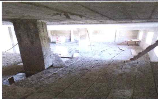
Foto 2: Blanqueado liso muros y losa
