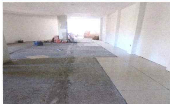
Foto 3: Sustitución de piso cerámico
