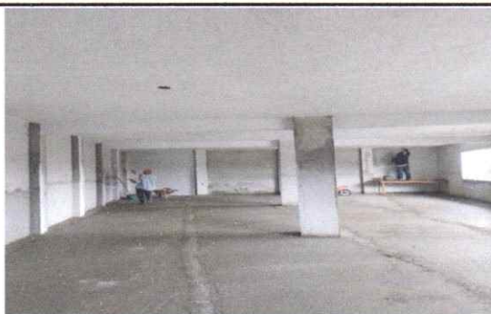
Foto 4: Sustitución de piso cerámico
