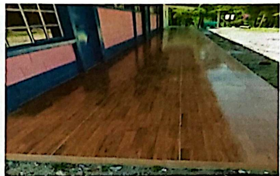
Sustitución de piso
