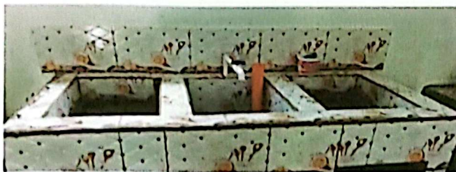
Reparación de lavatrastos
