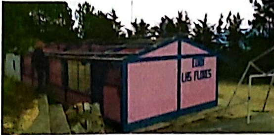
Sustitución de estructura metálica
