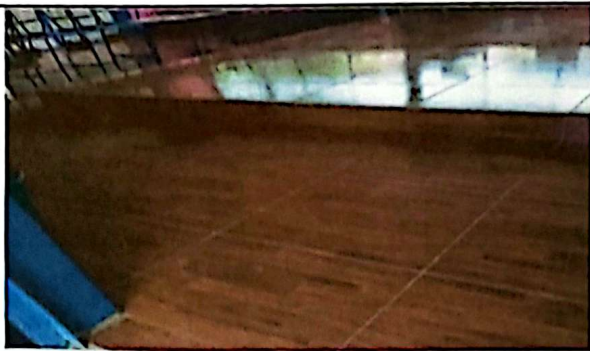
Sustitución de piso
