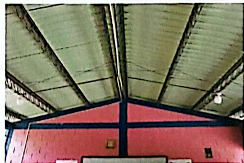
Instalación de energía eléctrica
