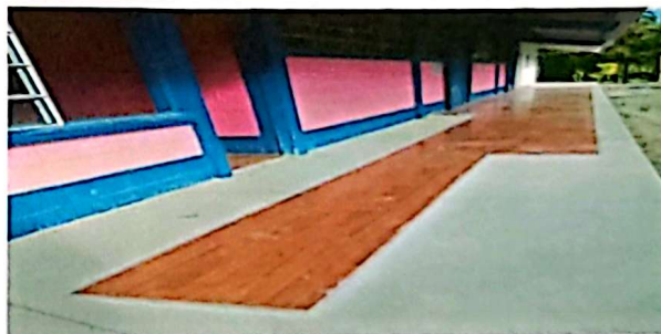
Sustitución de piso
