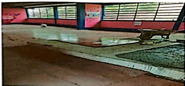
Sustitución de piso
