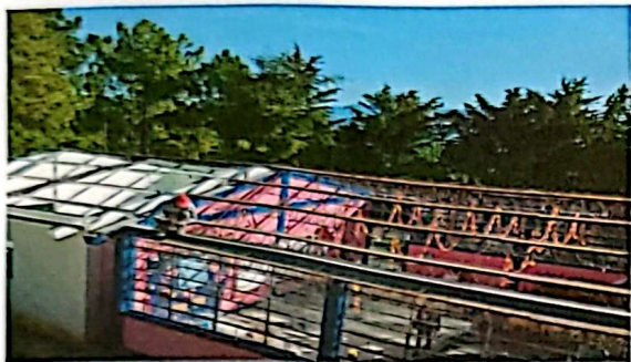
Sustitución de estructura metálica
