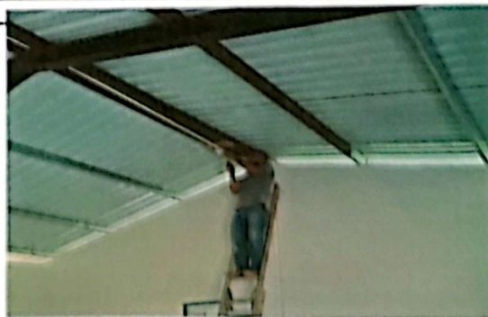
Instalación de Energía Eléctrica
