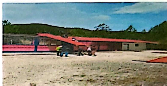
Sustitución de techo
