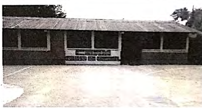
Imagen de inicio del remozamiento
