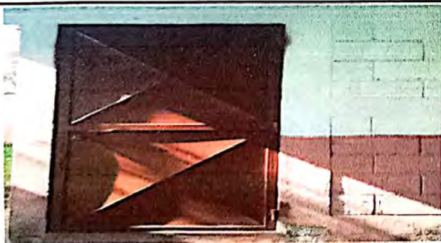
Imagen durante el remozamiento
