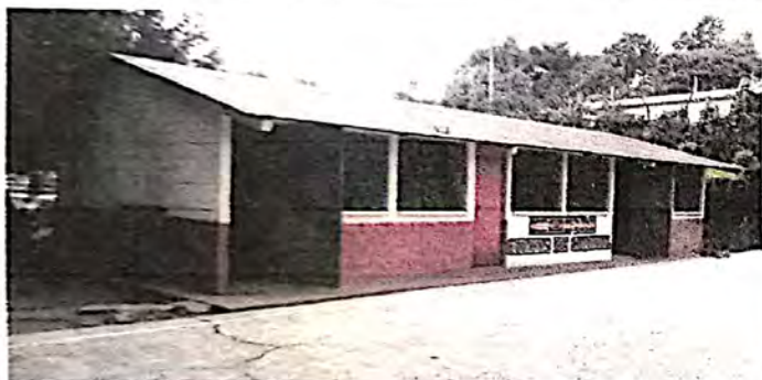
Imagen de inicio del remozamiento
