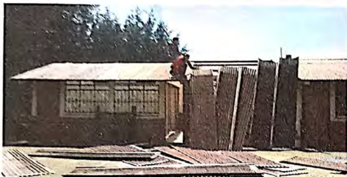
Imagen durante el remozamiento
