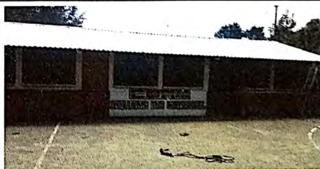
Imagen durante el remozamiento
