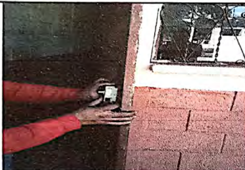
Imagen durante el remozamiento
