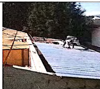
Imagen durante el remozamiento
