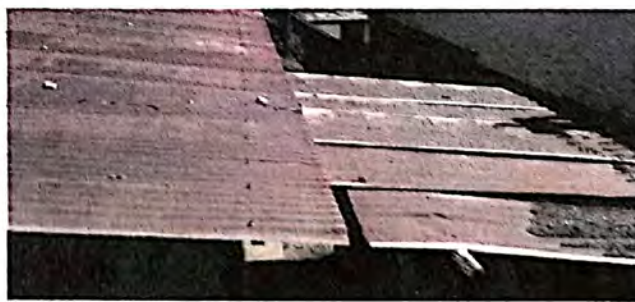
Imagen de inicio del remozamiento
