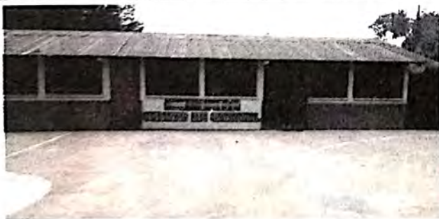
Imagen de inicio del remozamiento
