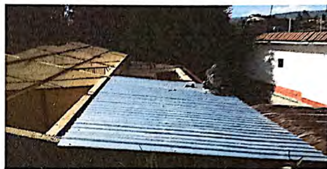
Imagen durante el remozamiento
