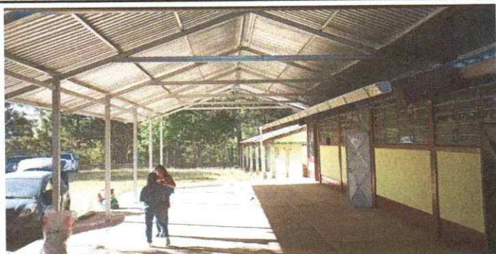
SUSTITUCION DE CERCHA TIPO PENDOLON PARA TECHO DE 2 AGUAS CON TUBO ESTRUCTURAL GALVANIZADO DE 4 X 4" COLOCADO AL 100%
