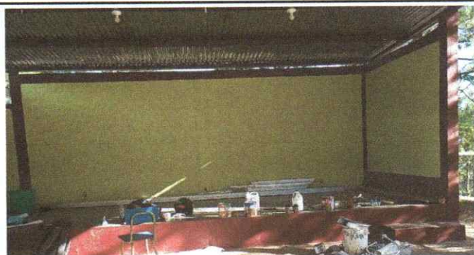
PINTURA DE LATEX EN MUROS EXISTENTES COMPLETO AL 100%
