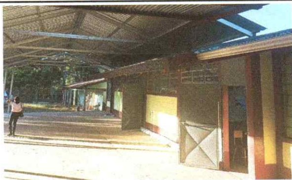
SUSTITUCION DE TENDALES PARA LAMINA, CON COSTANERA GALVANIZADA DE 2 X 4", MANTENIMIENTO DE PUERTA METALICA EXISTENTE COMPLETO AL 100%
