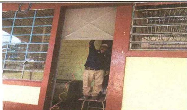
MANTENIMIENTO DE PUERTAS EXISTENTES
