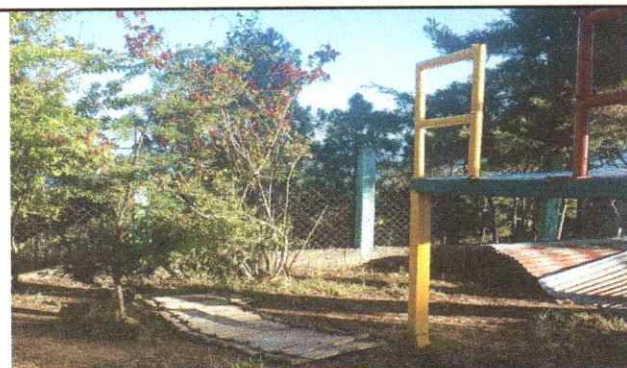
RETIRO DE PUENTE PEATONAL INFANTIL
