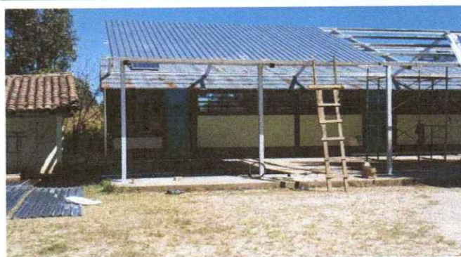
COLOCACION DE LAMINA TROQUELADA
