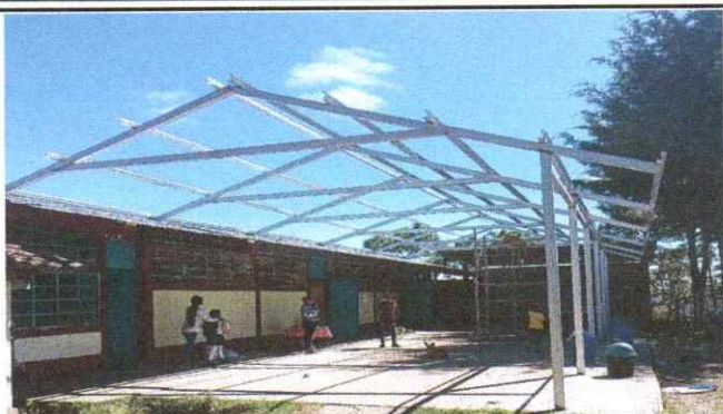
SUSTITUCION DE CERCHA TIPO PENDOLON PARA TECHO DE 2 AGUAS CON TUBO ESTRUCTURAL GALVANIZADO DE 4 X 4"
