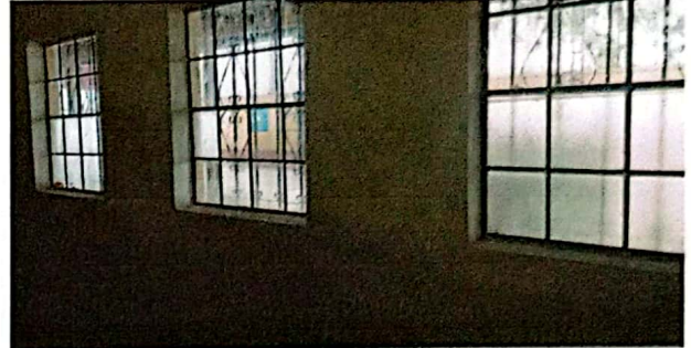
Foto 2: repello de paredes de aulas finalizado al 100%
