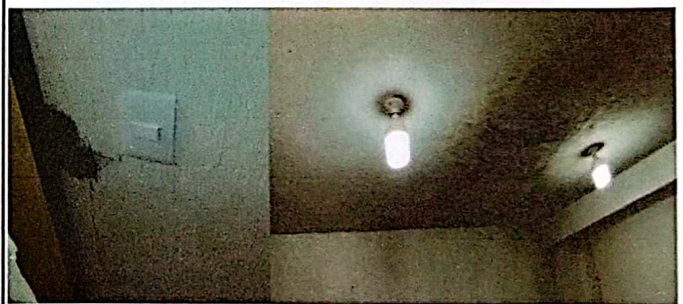
Foto 6: instalacion electrica en aula finalizado 100%
