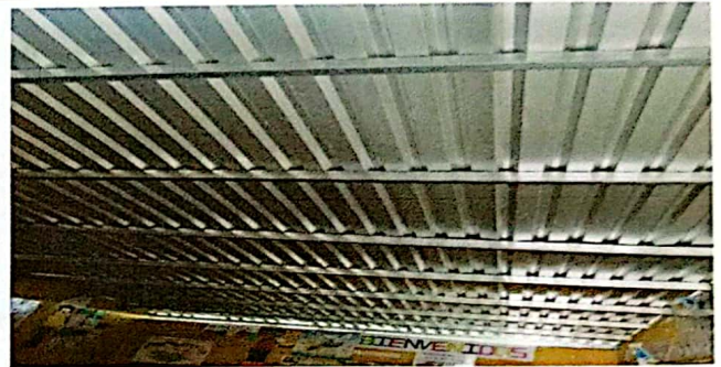
Foto 4: instalacion de láminas vista interior
