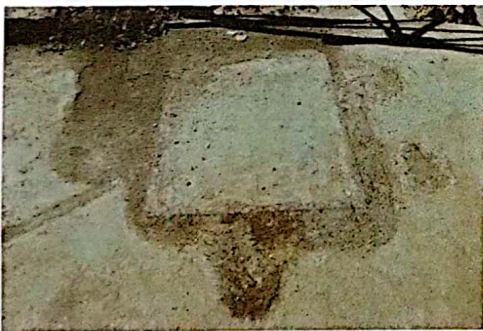
Foto 5: limpieza de fosa séptica finalizado 100%
