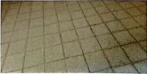
Foto 1: instalacion de piso finalizado al 100%
