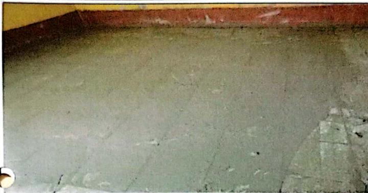
Foto1: Suministro e instalación de piso
