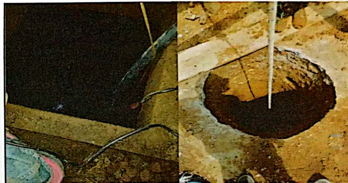
Foto 4: Limpieza de Fosa Septica
