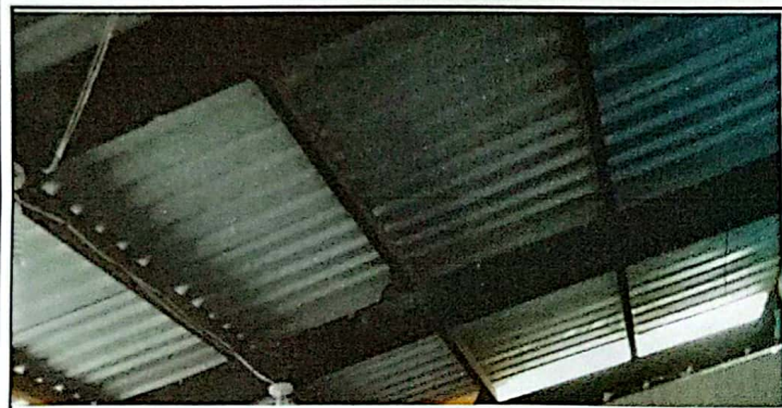
Foto 3: Suministro e instalación Láminas
