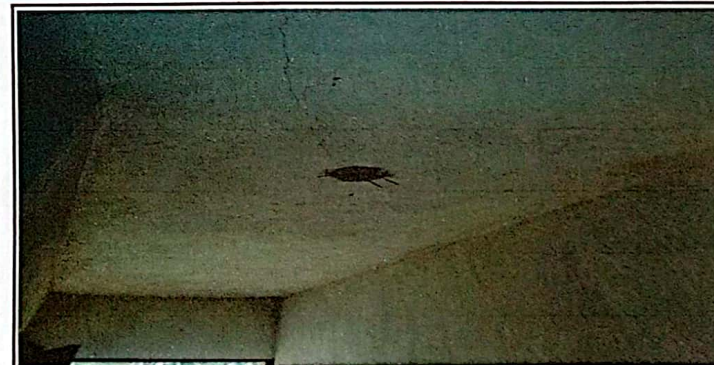
Foto 6: suministro e instalación de enegia eléctrica.
