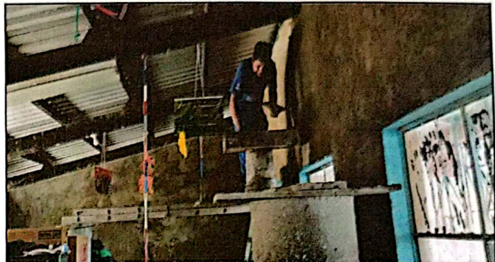
Foto 2: suministro y aplicación de repello en paredes
