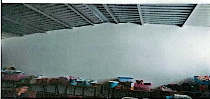
Foto 3: VISTA DE FRENTE DEL SUMINISTRO E INSTALACIÓN DEL MURO PREFABRICADO 100%
