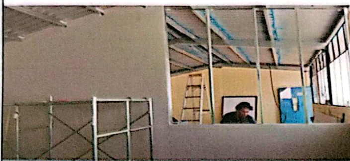
Foto 1: SUMINISTRO E INTALACIÓN DE TABLA YESO EN DIVISIÓN ENTRE 2 AULAS
