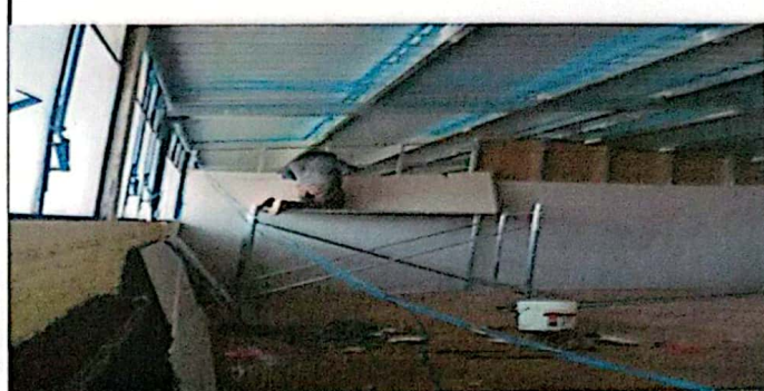
Foto 2: MURO PREFABRICADO DE TABLA YESO
