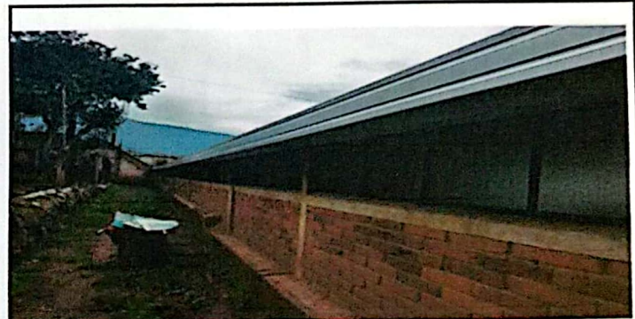
Foto 4: SUSTITUCIÓN AL 100% DE LOS VIDRIOS DE LAS CUATRO AULAS
