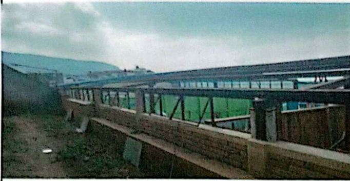
Foto1: VISTA DE LA PARTE DE ATRÁS DE LAS VENTANAS YA CON LOS VIDRIOS RETIRADOS
