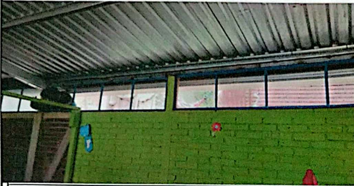
Foto 3: AVANCE DEL CAMBIO DE VIDRIOS EN EL AULA 3
