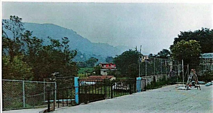
FOTO 3: FINALIZACION DE INSTALACION DE MALLA
