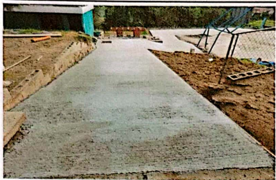
Foto1: FUNDICION DE ACCESO A LA ESCUELA 100%
