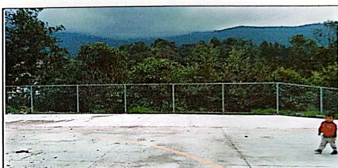
Foto 4: INSTALACION DE MALLA DE PREVENCION AL 100%
