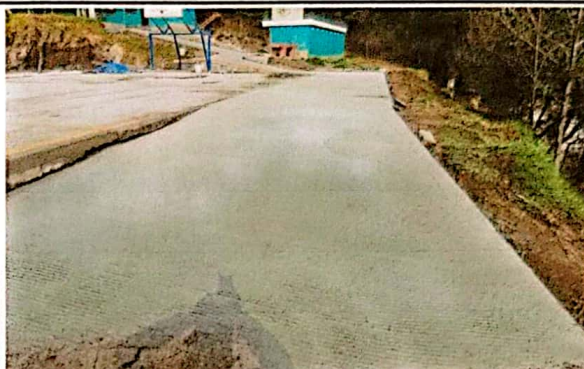
Foto 2: FUNDICION DE ACCESO A LA ESCUELA FINALIZADO
