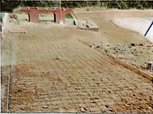
Foto 1: SUMINISTRO E INSTALACIÓN DE TORTA DE CONCRETO DE 3000 PSI CON ELECTROMALLA ( t=10 CM).
