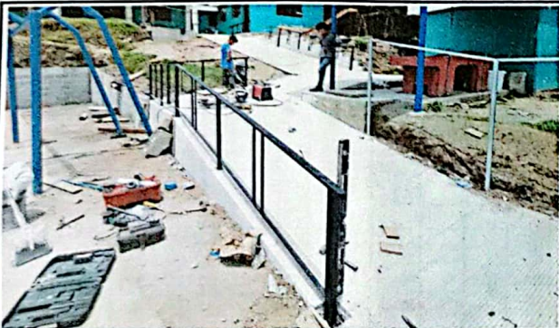
Foto 5: SUMINISTRO E INSTALACIÓN DE BARANDAS DE METAL DE TUBO MECANICO NEGRO DE 1 1/2" CHAPA 16.
