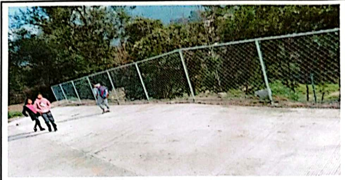
Foto 4: SUMINISTRO E INSTALACIÓN DE MALLA PERIMETRAL DE 1.50 M DE ALTO X 35 M DE LARGO.
