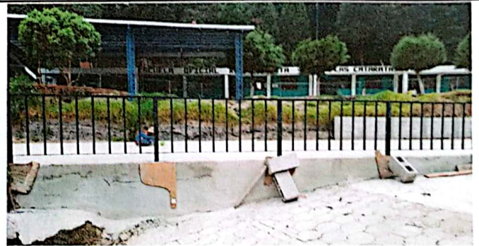
Foto 6: SUMINISTRO E INSTALACIÓN DE BARANDAS DE METAL DE TUBO MECANICO NEGRO DE 1 1/2" CHAPA 16.
