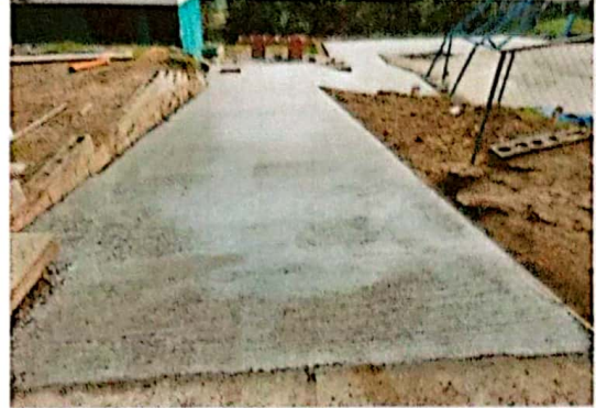
Foto 2: SUMINISTRO E INSTALACIÓN DE TORTA DE CONCRETO DE 3000 PSI CON ELECTROMALLA ( t=10 CM).
