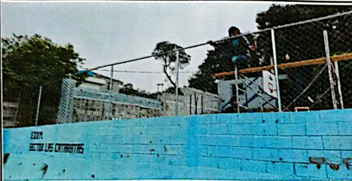
Foto 3: SUMINISTRO E INSTALACIÓN DE MALLA PERIMETRAL DE 1.50 M DE ALTO X 35 M DE LARGO.
