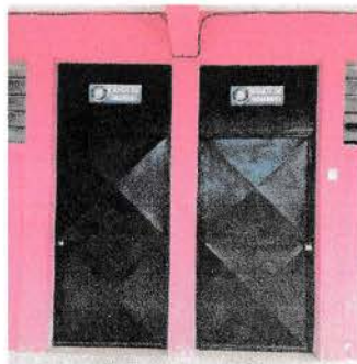
9.- MANTENIMIENTO DE PUERTA DE INGRESO (reduccion de altura y aplicación de pintura)
