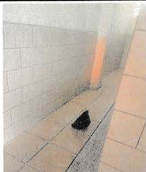
3.- COLOCACION PISO CERAMICO ANTIDESLIZANTE (a instalar sobre piso existente)
