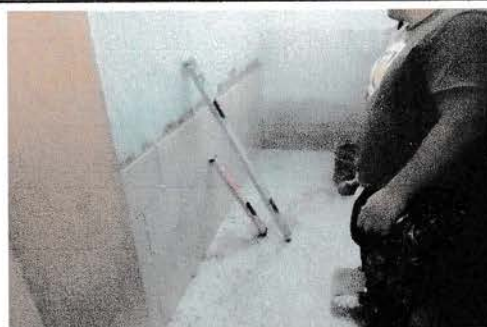
2.- COLOCACION DE AZULEJO h = 1.8 m en area de artefactos sanitarios resto h = 1.2 m (incluye remocion de existente),
