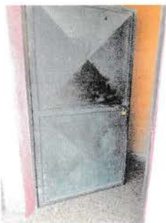
9.- MANTENIMIENTO DE PUERTA DE INGRESO (reduccion de altura y aplicación de pintura)
