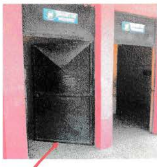
9.- MANTENIMIENTO DE PUERTA DE INGRESO (reduccion de altura y aplicación de pintura)
