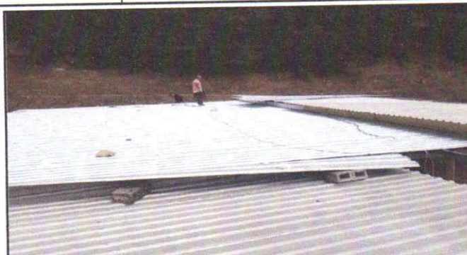
Foto 2: VISTA DE INSTALACIÓN DE LÁMINA FINALIZADO
