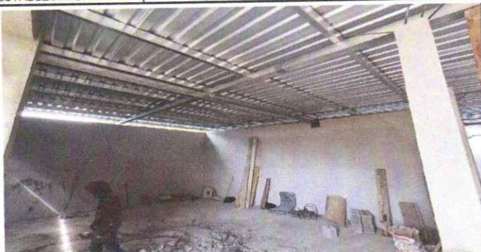
Foto 1: VISTA FACHADA INTERIOR LAMINA COLOCADA AL 100%
