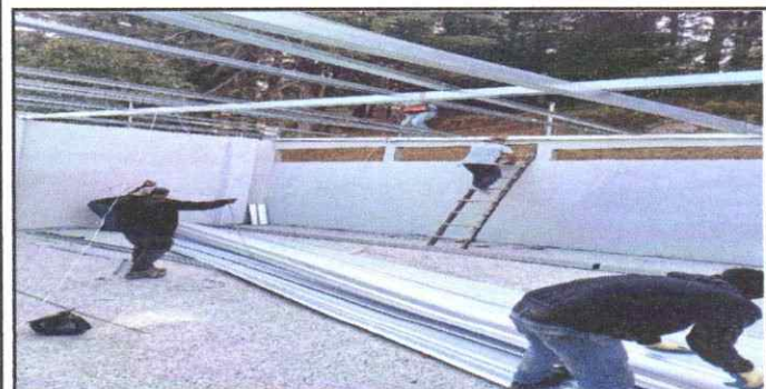
Foto 5: SUMINISTRO E INSTALACION DE TECHO PORTANTE
