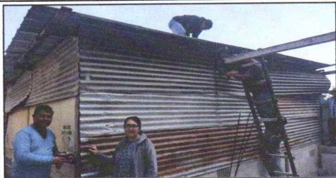
Foto1: RETIRO DE LÁMINAS ANTIGUAS
