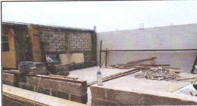
Foto 2: SUMINISTRO DE SUSTITUCION DE REPELLO
