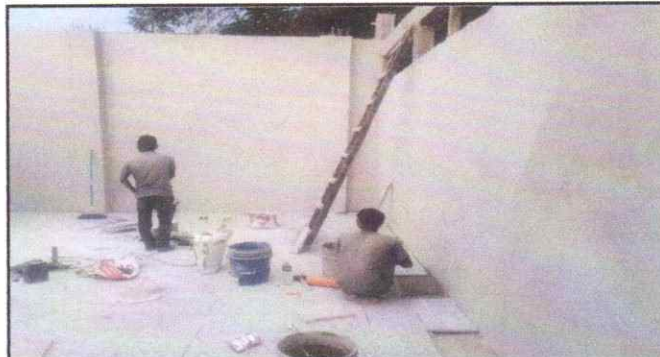
Foto 4: SUMINISTRO DE SUSTITUCION DE PISO
