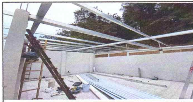
Foto 6: FINALIZA LA COLOCACIÓN DE TECHO PORTANTE
