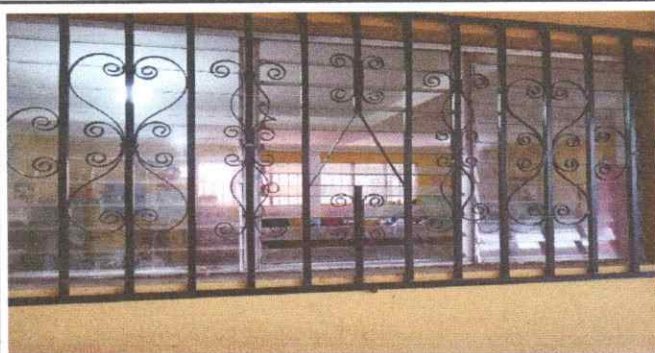
Mantenimiento de balcones
