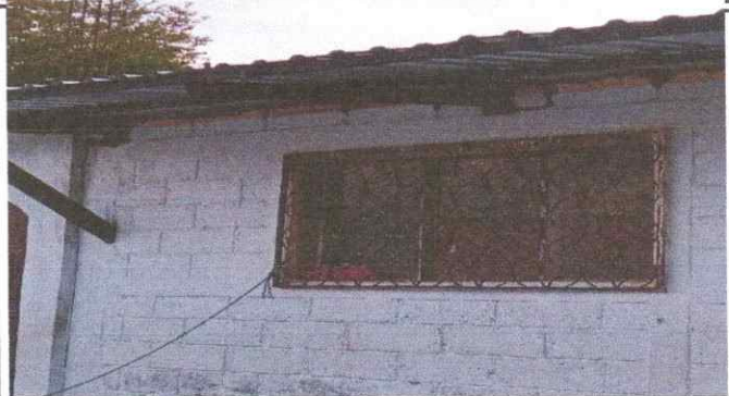
Mantenimiento de balcones
