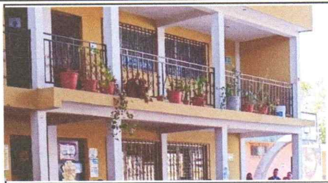
Mantenimiento de balcones
