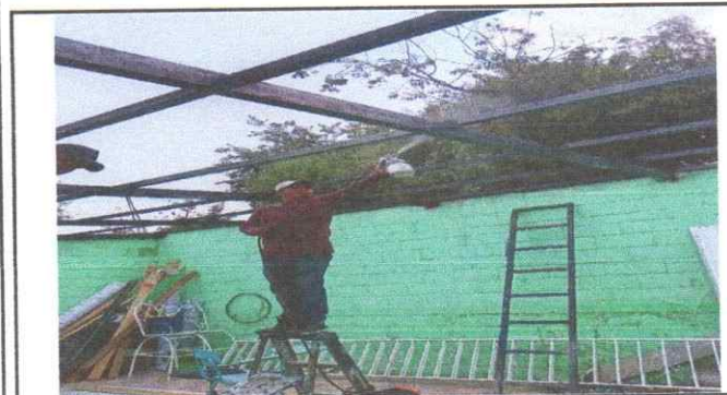
Sustitución de estructura de madera por estructura de metal y lámina troquelada calibre 26, y estructura prefabricada y puertas de madera por puertas de metal
