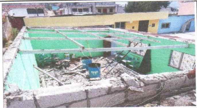
Sustitución de estructura de madera por estructura de metal y lámina troquelada calibre 26, estructura prefabricada y puertas de madera por puertas de metal
